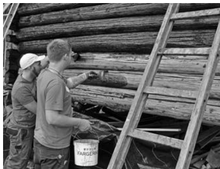
Martin Garmo og Shenoll Belegu gir vengeburet på Evju et sårt tiltrengt strøk med tjære.
